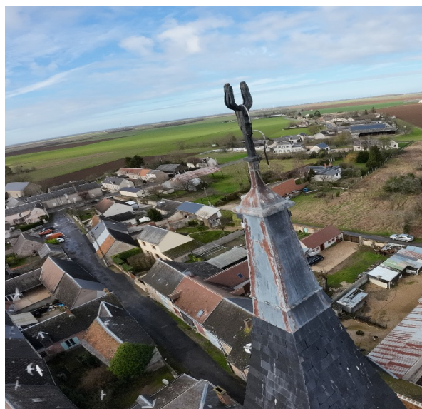
Vue depuis un drone du support de la croix de Notre Dame d'Asnières
