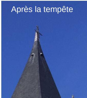
La croix retenue par les câbles du paratonnerre
