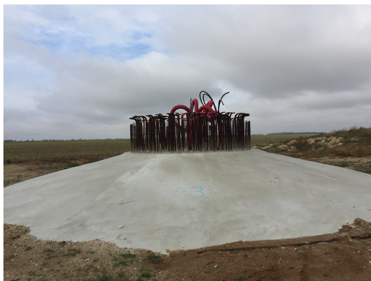
Support d'éolienne en attente
